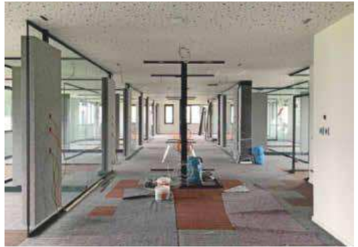
/ Durch einen hohen Vorfertigungsgrad konnte der Ausbau des 3. Obergeschosses der Bischöflichen Finanzkammer in nur sieben Montagetagungen erfolgen.
