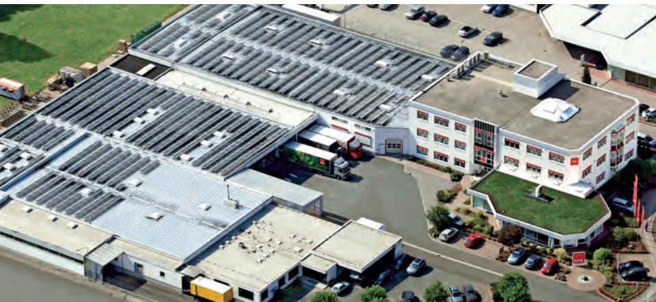
Blick auf das Werksgelände der Köhl GmbH in Rödermark.
